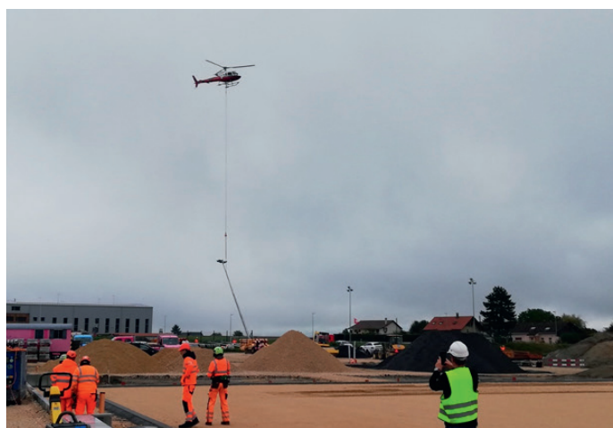
Pose des mats d'éclairage à l'hélicoptère
